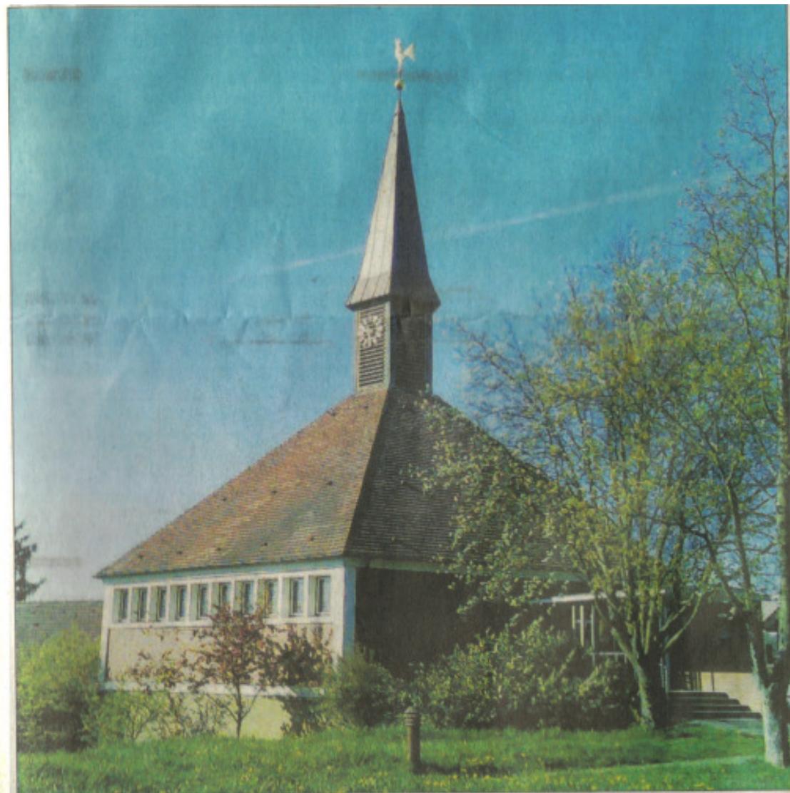
Das neue Dach des Schönberger Glockenturms glänzt in der Frühlingssonne. Allerdings ist es noch nicht abbezahlt.
